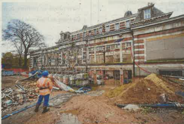
De gevel staat in de steigers. FOTO JAN VAN DE PERRE
